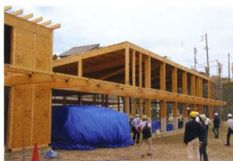
SE構法によって建築中の木造非住宅施設(写真提供:NCN)
