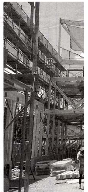
小屋トラスにFロールしながら
