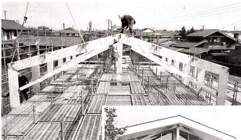
P3+自立型フレーム(スパン11m、鉛直支持のため中間柱を設置)で、開放感のあるヤスタヨーグルト店舗(新潟県)
