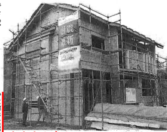
トステム21世紀住宅研究所の「スーパーバリュー」の施工現場。耐震等級3相当の構造設計と梁組のチェックで図面と現場の完全な一致を実現
