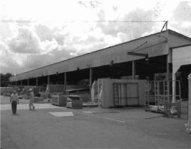
手組の作業場
